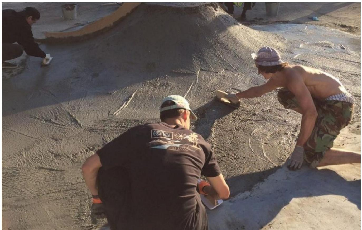
Скейтеры обустроили парк с помощью подручных средств и строительного мусора. Однако работу они постарались сделать максимально качественно: «основной упор был на затирку бетона вручную, для получения идеально гладкого покрытия».
