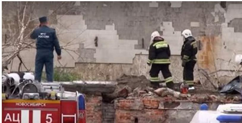
Обрушение конструктивных элементов здания скотобойни 1920-х г.г. постройки на территории мясокомбината произошло в ходе проведения работ по его демонтажу. В результате один человек погиб, трое пострадали.
