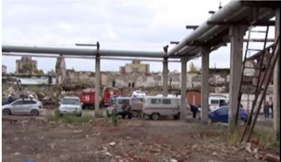
Как удалось установить прокуратуре, обрушение конструктивных элементов здания скотобойни 1920-х г.г. постройки на территории мясокомбината произошло в ходе проведения работ по его демонтажу.
