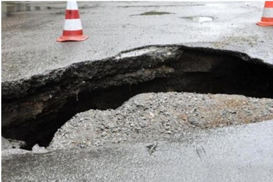
Сведения о прорыве магистрального теплопровода диаметром 500 мм и провале дорожного полотна у дома № 276 по ул. Дуси Ковальчук поступили в 1:30 ночи.
