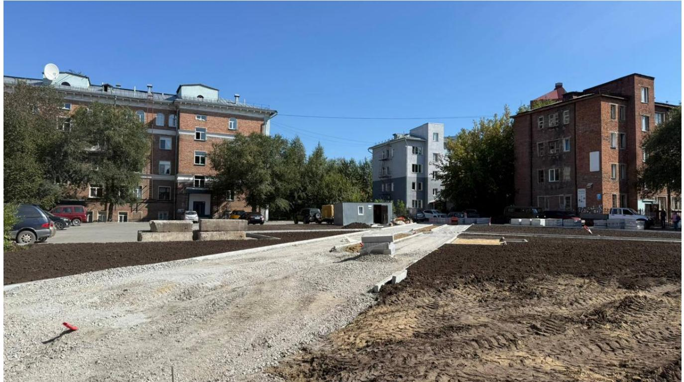
«На улице Котовского уже установлены бордюры, устроено основание пешеходных дорожек, проложен кабель электроснабжения. Сейчас ведётся подготовка к укладке плитки и устройству лестницы, завозят грунт для озеленения», – уточнил мэр.
