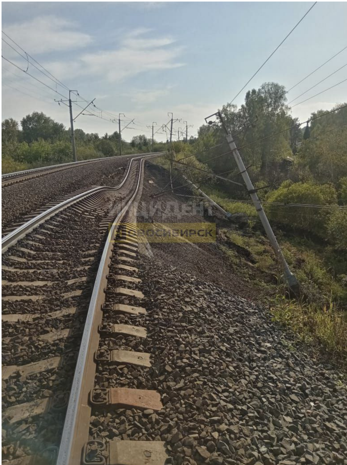
На участке между станциями «Жеребцово» и «Издревая» Западно-Сибирской железной дороги произошёл спływ земляной насыпи, что привело к повреждению железнодорожных путей.
