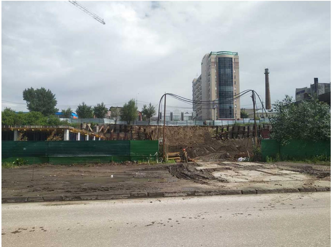
10 июня в результате постоянного размыва грунта подземными коммуникациями и дождями обрушилась опорная стена котлована «Снежной мили». Это привело к повреждению части дороги и тротуара – земля ушла в овраг вместе с ограждением из профнастила.
