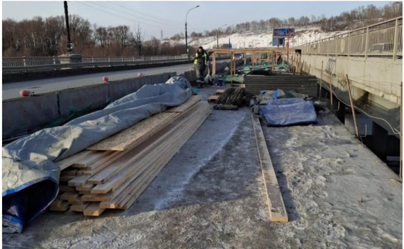
В Новосибирске на Бердском шоссе возобновили ремонт моста через реку Иня. Сейчас подрядчики обустраивают временные островки в русле реки, чтобы поднять пролёты моста и заменить повреждённую арматуру, которая подверглась коррозии. Будут установлены новые высокопрочные канаты и произведено бетонирование. Об этом сообщил мэр города Максим Кудрявцев в своем Telegram-канале.
