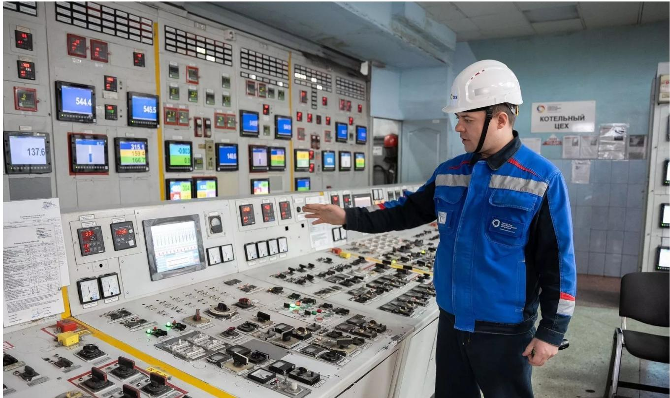
Новая система управления подачей измельченного в пыль угля заработала на 10-м котле Новосибирской ТЭЦ-4. Реализация проекта стоимостью 13 млн рублей позволяет повысить надежность и коэффициент полезного действия котлов. Об этом сообщает АО «СГК-Новосибирск».
