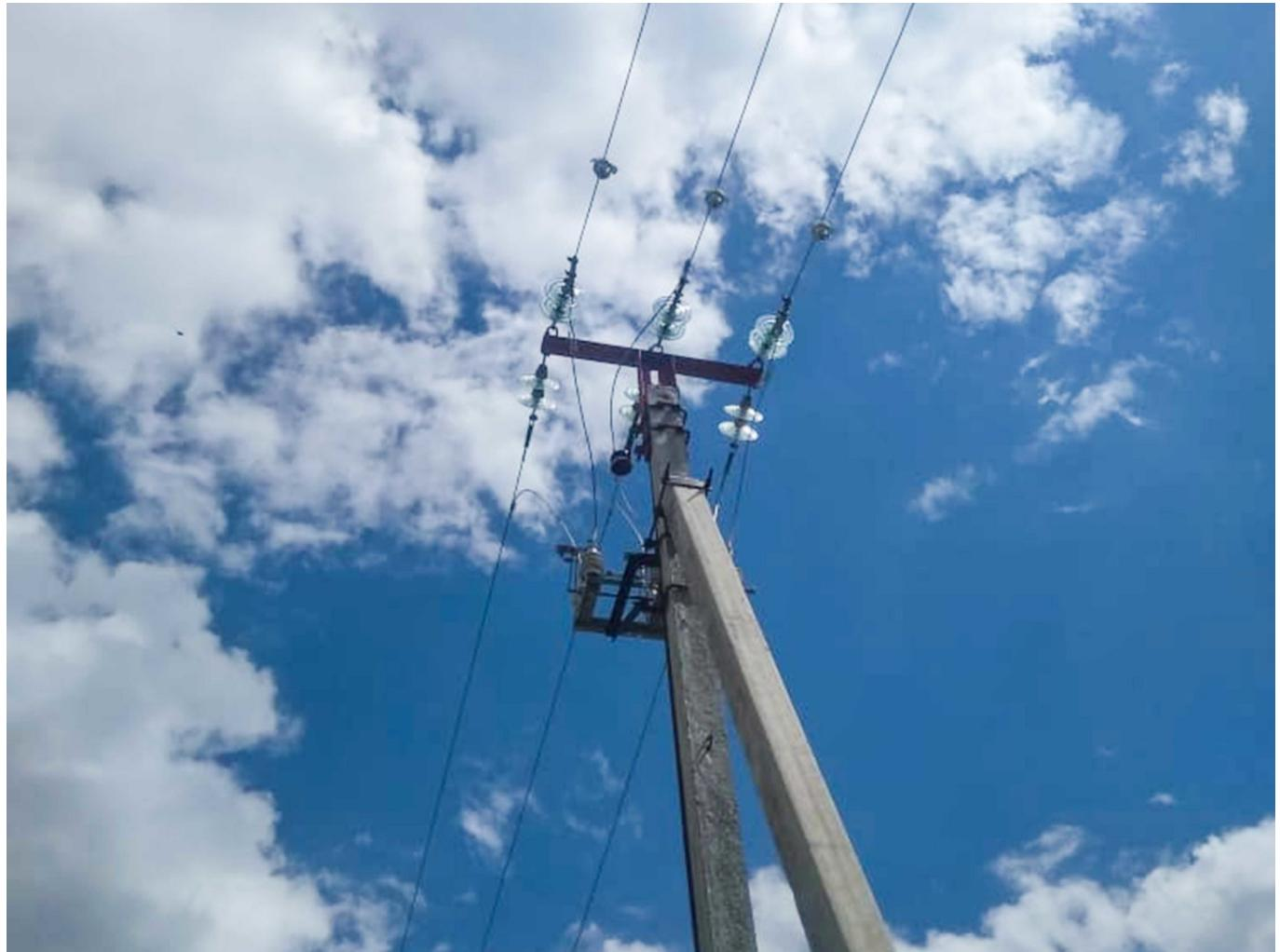
Например, 32 опоры заменили на воздушной линии электропередачи 10 кВ в Барабинском районе области. Здесь энергетики в рамках подготовки электросетей к отопительному сезону установили новые железобетонные конструкции вместо деревянных опор. На эти цели компания направила более 1 млн рублей.
