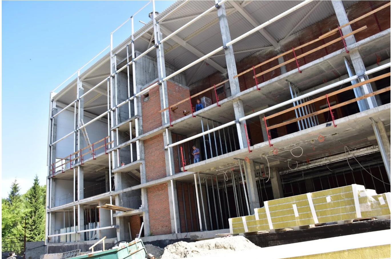
Сегодня строители вышли на финишную прямую по обустройству кровли и остеклению спорткомплекса, приступили к внутренним отделочным работам и установке оборудования в чаше бассейна.
