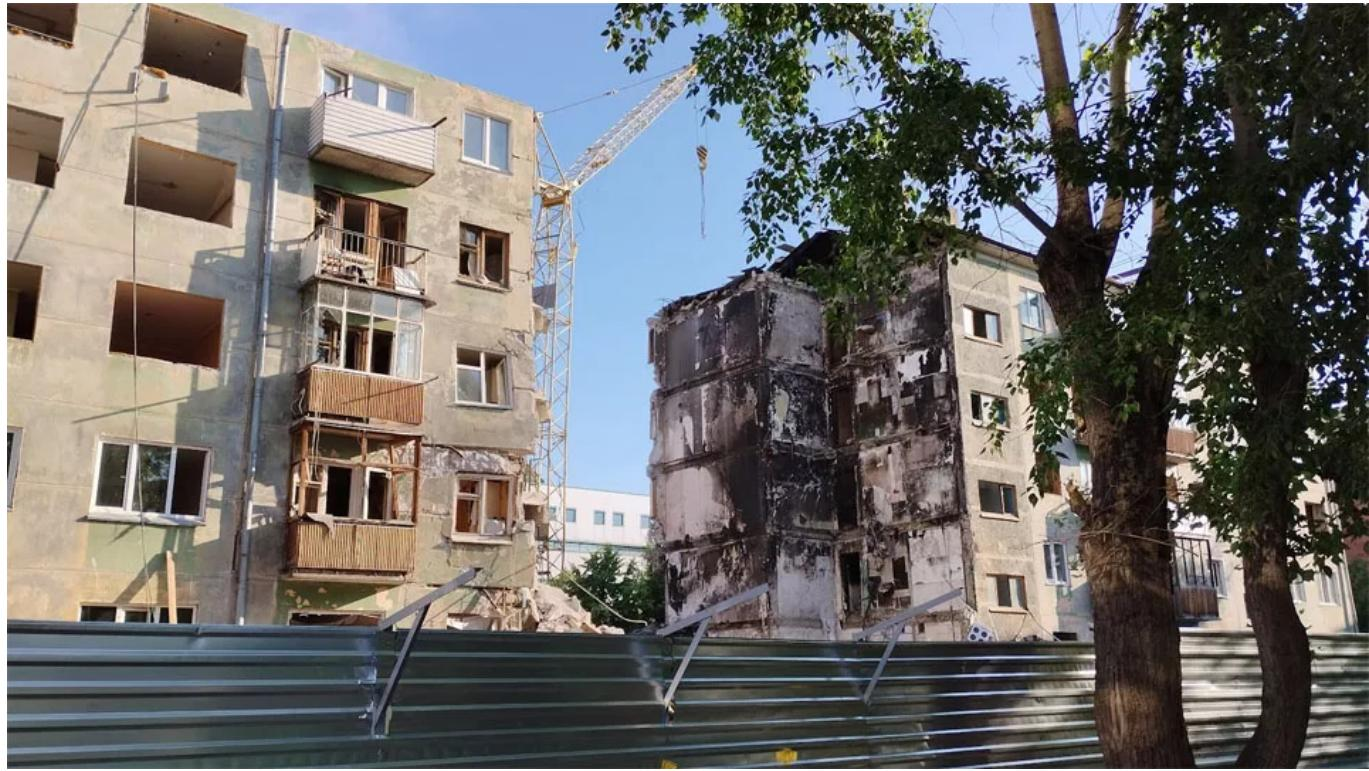
Подрядчик приступил к непосредственному демонтажу панельной пятиэтажки на ул. Линейная, 39, в Заельцовском районе Новосибирска. Здание огорожено, кран успел разобрать пока только кровлю и чердак одной из уцелевших частей дома.
