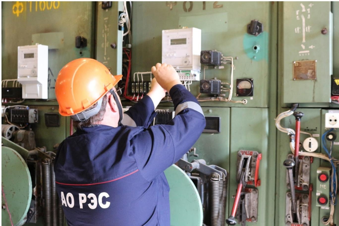
В рамках [долгосрочной комплексной программы по работе с потерями электрической энергии](#) в АО «РЭС» активно устанавливаются интеллектуальные системы технического учета электроэнергии в распределительных подстанциях 10/0,4 кВ.
